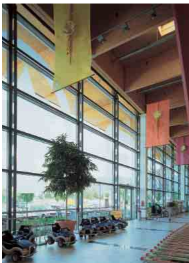
Торговый центр Interspar, г. Фельдкирх, Австрия Shopping mall Interspar, Feldkirch/A
