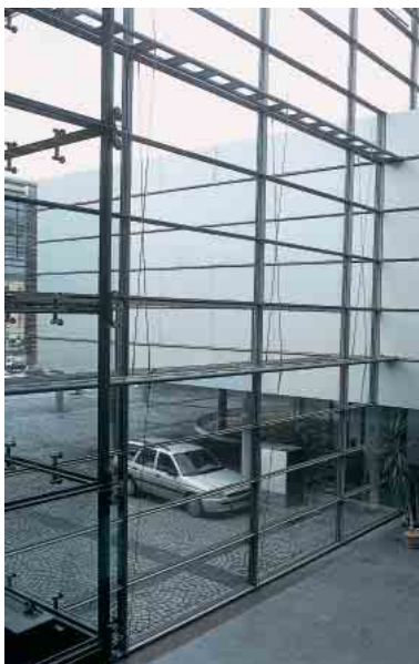
Здание областного суда, г.Мейнинген, Германия Regional court building, Meiningen/D
