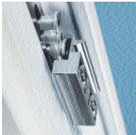
Закрепленные в стальной ответной планке элементы с грибовидными головками повышают надежность запираания
