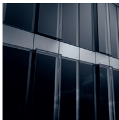
Фасад с параллельно-отставным окном Façade with parallel-opening unit
