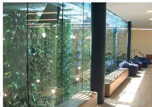
Остекление EI30 с вертикальными силиконовыми швами F30 glazing with vertical silicone joints
