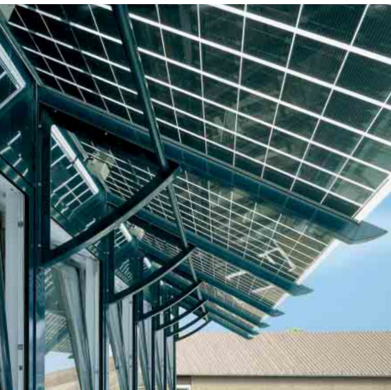
Защита от непогоды плюс источник энергии на фасаде: TopSky I с фотоэлектрическими элементами Weather protection plus a source of energy on the façade: TopSky I with photovoltaic units
