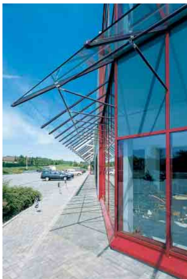
Решение с разными углами наклона: TopSky II с прозрачным остеклением Solution with variable angle: TopSky II with transparent glazing
